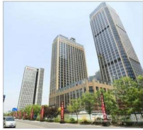
杭州宝盛世纪中心 Hangzhou Binsheng Century Center 地点(Place): 杭州 Hangzhou 面积(Area): 28000m² 地板类型(Panel Type): OA网络地板
