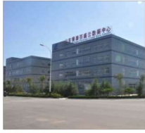
山东银盾云计算处理中心 Shandong Peng Silver Cloud Computing Center 地点(Place): 山东 Shandong 面积(Area): 12000m² 地板类型(Panel Type): 硫酸钙网络地板
