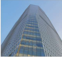
上海惠鲁工厂 Shanghai Med Office Building 地点(Place): 上海 Shanghai 面积(Area): 12000m 2 地板类型(Panel Type): OA网络地板
