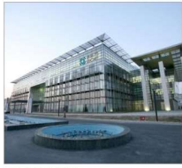
北京东方运营中心 Beijing Dong Fang operations center 地点(Place): 北京 Beijing 面积(Area): 30000m² 地板类型(Panel Type): OA网络地板
