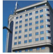
北京电信通信指挥楼 China Telecom (Beijing) Office Building 地点(Place): 北京 Beijing 面积(Area): 15000m² 地板类型(Panel Type): HPLC防静电地板
