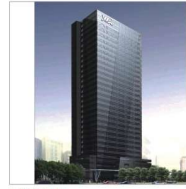
深圳威盛大厦 Shenzhen Wansheng Building 地点(Place): 深圳 Shenzhen 面积(Area): 30000m² 地板类型(Panel Type): OA网络地板
