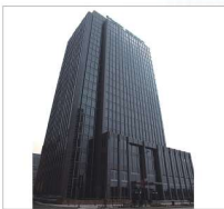
上海长丰大厦 Shanghai Changfeng Building 地点(Place): 上海 Shanghai 面积(Area): 22000m 2 地板类型(Panel Type): OA网络地板
