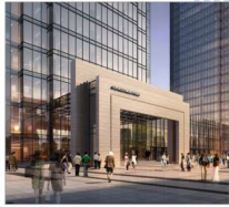
株洲高科 Zhuzhou Geoke 地点(Place): 株洲 Zhuzhou 面积(Area): 15000m² 地板类型(Panel Type): OA网络地板
