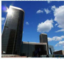
北京国贸大厦 Beijing International Trade Building or Cera Building 地点(Place): 北京 Beijing 面积(Area): 18000m² 地板类型(Panel Type): OA网络地板
