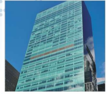
南昌绿地新都会 Nanchang Greenland Center 地点(Place): 南昌 Nanchang 面积(Area): 20000m² 地板类型(Panel Type): 新型砖网地板
