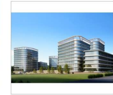
南京软件和软件园 Nanjing meib software park 地点(Place): 南京 Nanjing 面积(Area): 15000m 2 地板类型(Panel Type): OA网络地板
