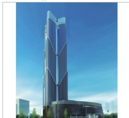
南昌银行金融服务中心 Nanchang Bank Financial Services Centre 地点(Place): 南昌 Nanchang 面积(Area): 20000m 2 地板类型(Panel Type): 硫酸钙网络地板
