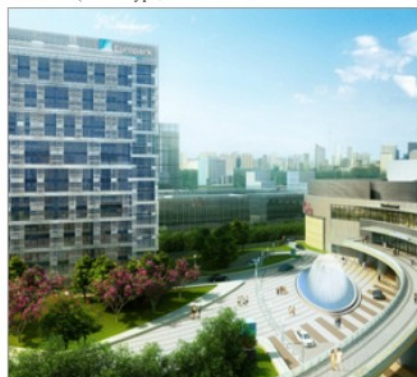
大连凯丹广场 Dalian Galleria 地点(Place): 大连 Dalian 面积(Area): 12000m 2 地板类型(Panel Type): 网络地板
