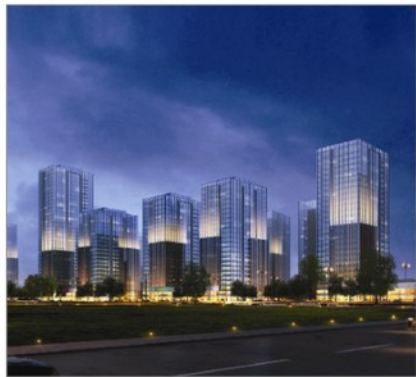
盐城金融城 Yancheng Financial City 地点(Place): 盐城 Yancheng 面积(Area): 145700m 2 地板类型(Panel Type): OA网络地板
