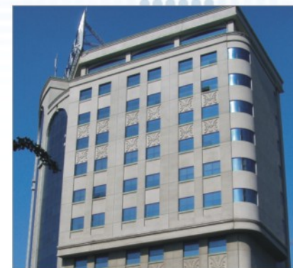
北京电信通信指挥楼 China Telecom (Beijing) Office Building 地点(Place): 北京 Beijing 面积(Area): 15000m 2 地板类型(Panel Type): HPL抗静电地板
