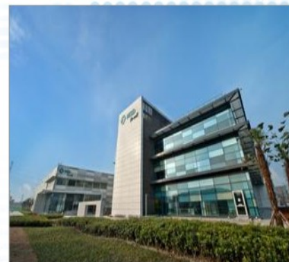
上海默沙东制药办公大楼 Shanghai Msd Office Building 地点(Place): 上海 Shanghai 面积(Area): 20000m 2 地板类型(Panel Type): OA网络地板
